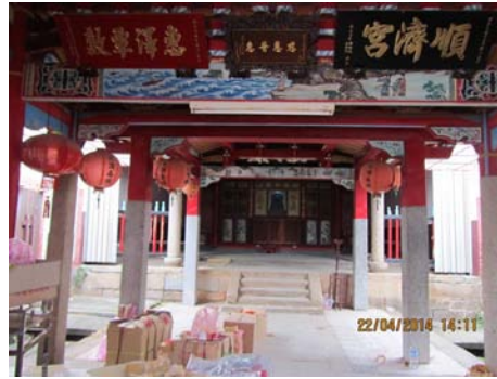
2014 拆除前的順濟宮內殿 (2014/4/22)
